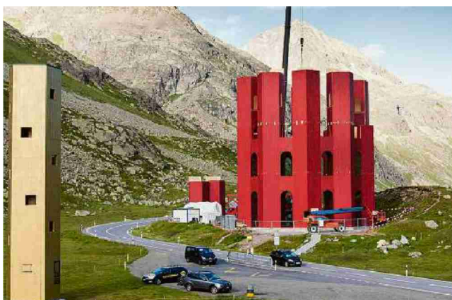
Aufbau im Jahr 2017: Bevor die grossen Holzelemente auf dem Julierpass zusammenfanden, wurden sie bei Uffer in Savognin in Einzelteilen gefertigt. Bilder Archiv
