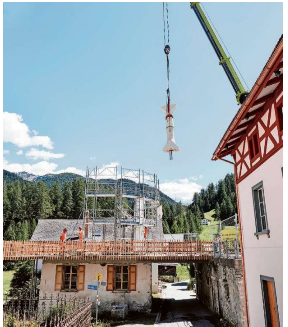
Cun ena crana èn las diesch pitgas neidas montadas.
