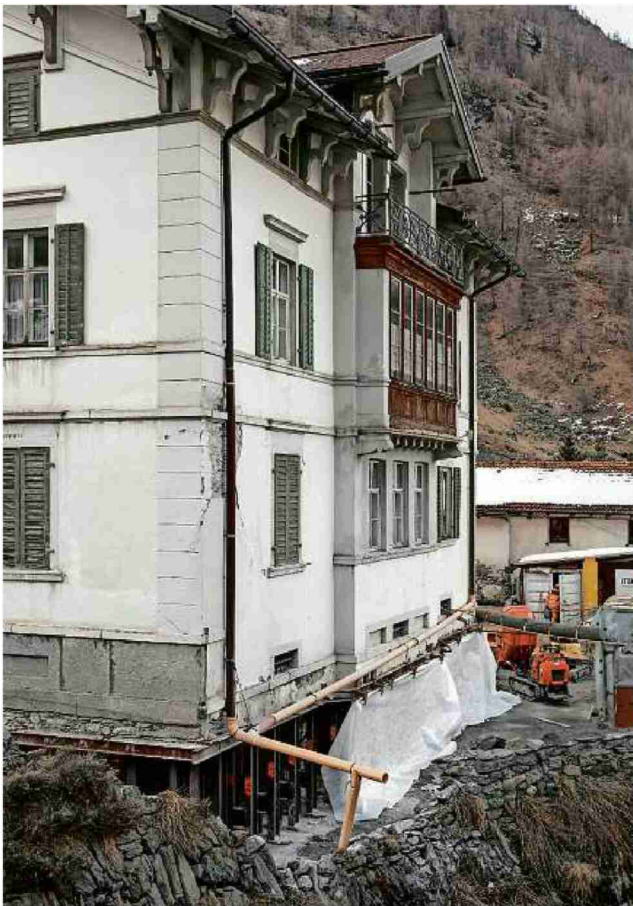
Luftiger Unterbau: Die «Weisse Villa» in Mulegns ist waagrecht abgesägt, das Mauerwerk unter dem Kellergewölbe abgetragen (rechts) und das ganze Gebäude auf Stahlstützen gestellt.
