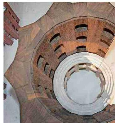
Ränge im Rund: Am Holzmodell ist der neue Einbau ersichtlich. Bild Jürg Oschwald
