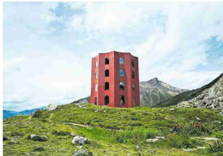
Auf dem Julierpass auf 2300 Metern über Meer steht bis 2020 dieser Theaterturm für das Origen-Festival. Bild: PD
